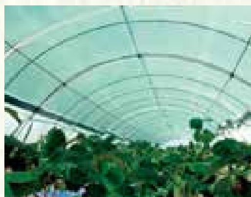
図4 有機薄膜太陽電池の設置状況
