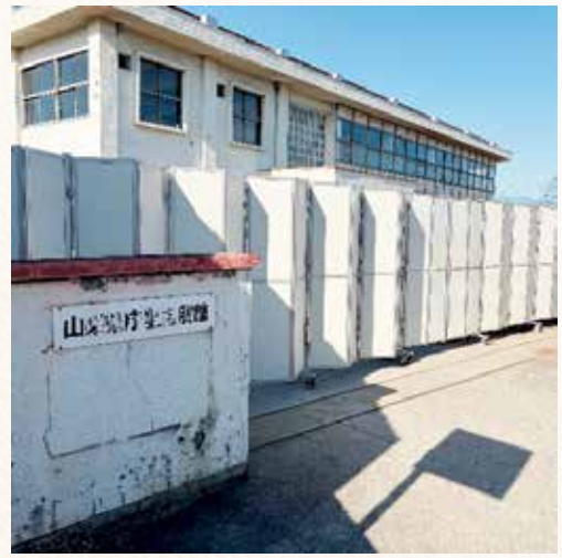
現在の里吉3-9-4： 県立工業技術センター → 県庁里吉別館 → 取り壊し中でした。この建物は北が勤めた病院ではありません。
